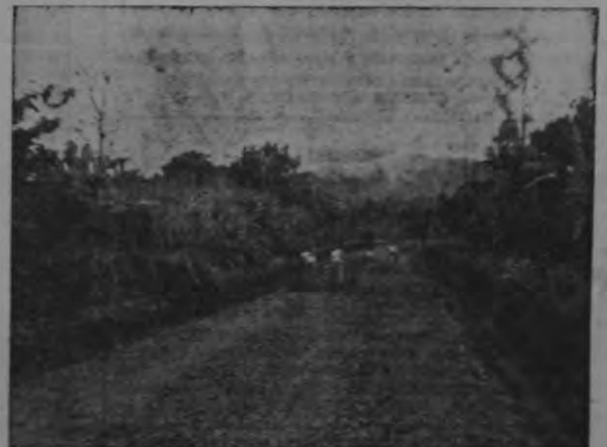
CAMINO VECINAL DE SAN RAMON-SAN RAFAEL.—Vista de la construcción de un nuevo camino vecinal entre San Ramón y San Rafael que se hace de acuerdo con el plan vial del Ministerio de Obras Públicas. — Caminos antes infranqueables, quedan gracias al MOP para tráfico en invierno y verano, dándole a muchas zonas una vida diferente.
